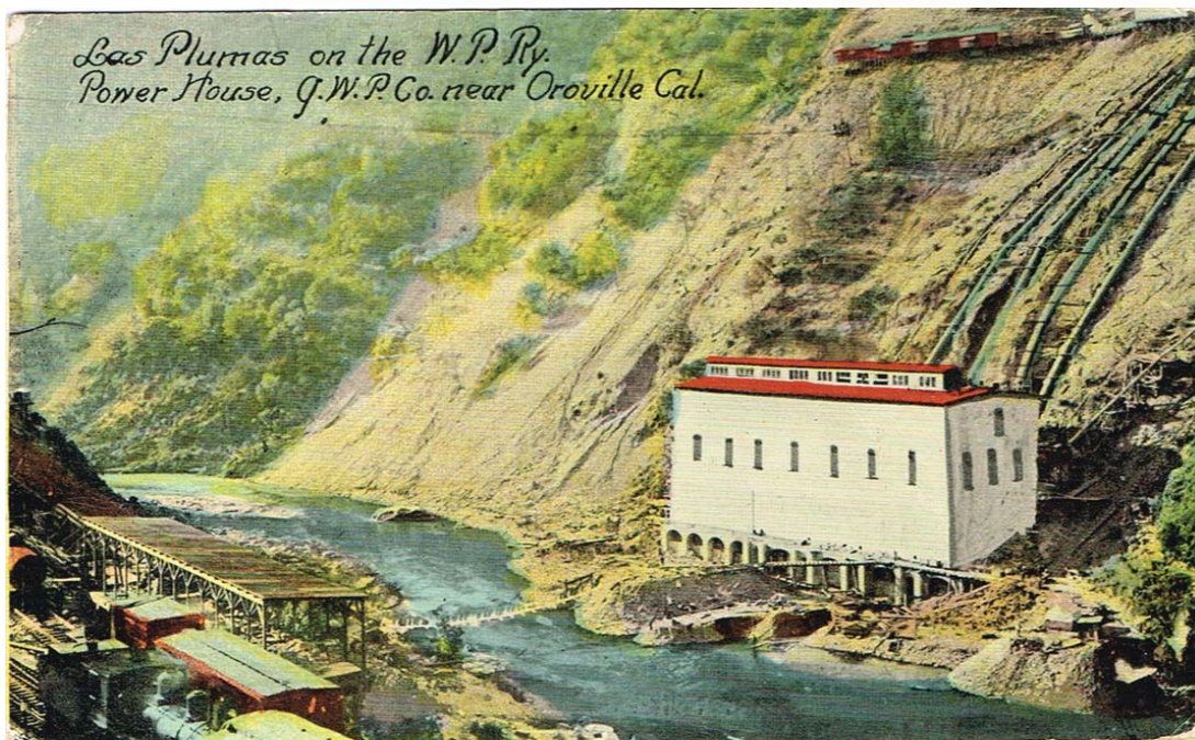
Las Plumas Power House 1911
