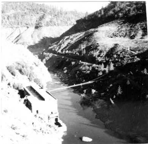
Feather River above Las Plumas Powerhouse.
